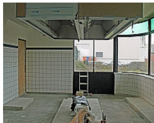
- keuken in aanbouw-
