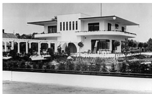
De villa en de tuin aan de achterkant (1939).
